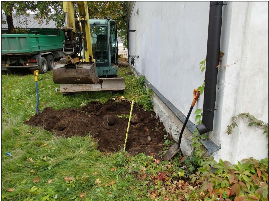
Kuvaussuunta pohjoiseen. Länsiseinustan eteläpäähän avattu kuoppa kuvan etualla. Taka-alalla erottuu saman seinustan pohjoispäähän tehty kuoppa.
