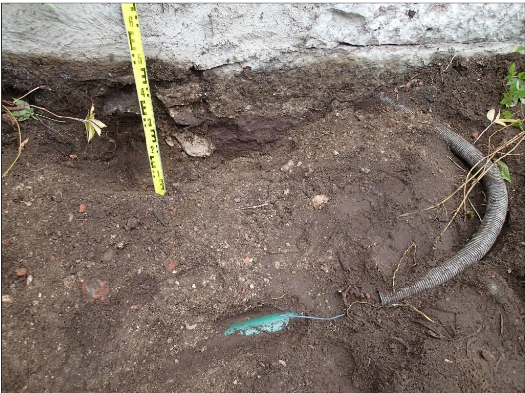
Puhelinkaapeli on ohjattu rakennuksen sisään eteläseinustan itäpäässä. Kaivannon maa on nurmimultaa, jonka seassa on tiili- ja laastimuruja. Yhtenäistä laastikerrostumaa ei havaittu tässä kaivannossa, mutta latan oikealla puolella näkyvä vaaleanharmaa laastikimpale sijaitsi nykyisen rakennuksen peruskivien ahtaassa raossa, jonne se vaikutti jääneen nykyistä rakennusta rakennettaessa. Nurmimullan alaista hiekkakerrostumaa ei havaittu myöskään tässä kuopassa.
